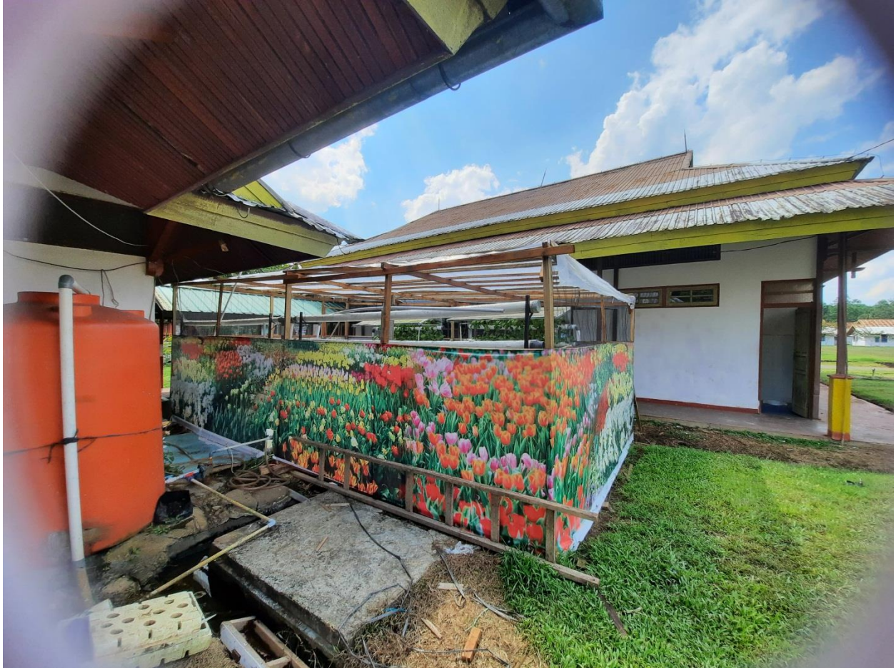
Rumah Bibit Hidroponik Tampak Samping dan Belakang
